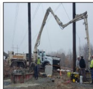
Camión de bombeo
