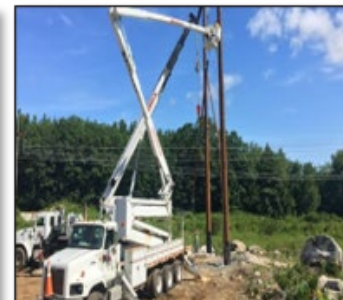
Camión grúa con cesta
