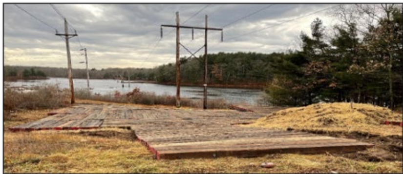
Esteras de madera (colocación)
